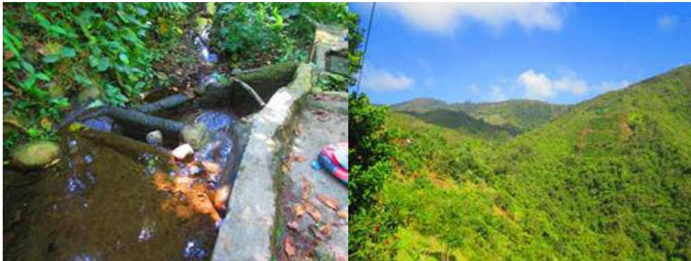
Fotografía. Acueductos Echandía y San Lorenzo fuente Piedra labrada.
