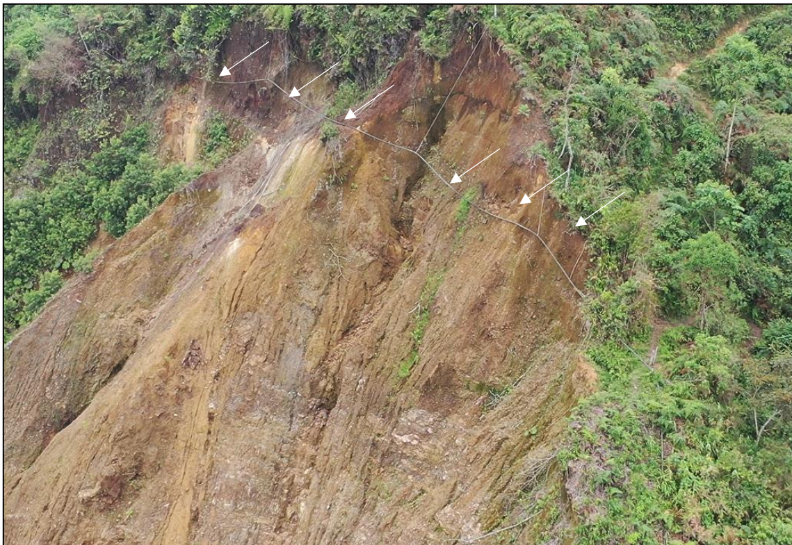
Detalle de la corona del movimiento en la ladera Sur, donde se aprecia el trazado o corrección de la línea de conducción del acueducto, luego de su traslado de la zona media alta del escarpe enunciada en el informe anterior (foto gracias al sobrevuelo con Dron).
