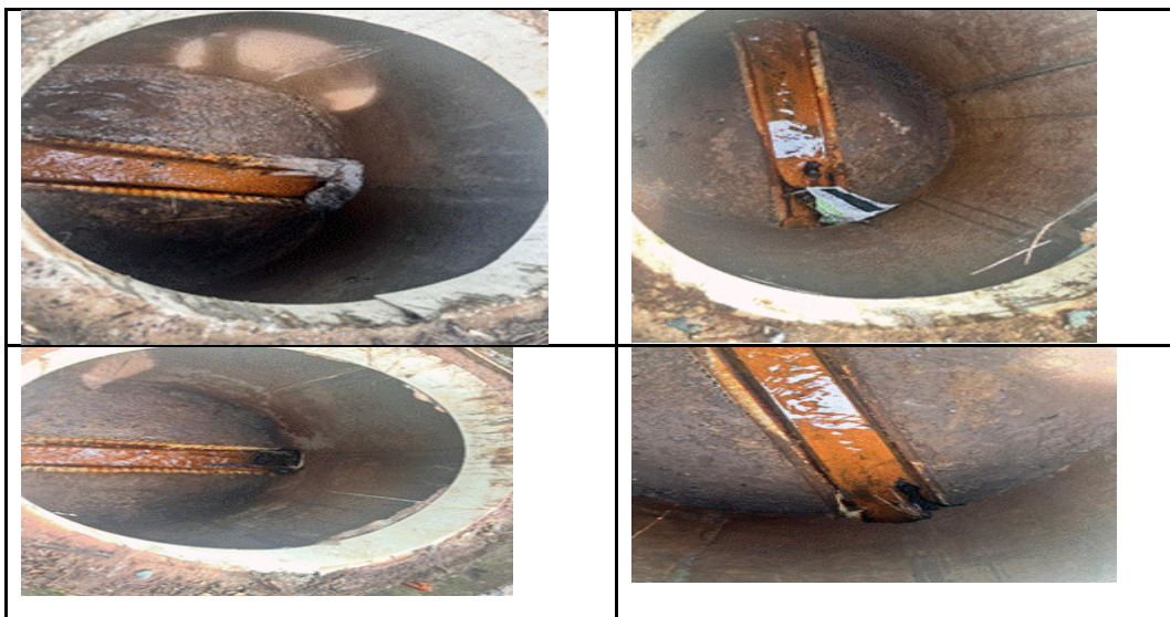
Imagen 2. residuos en las tuberías
