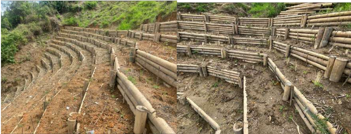
Muros armados en tierra Parcela No 1.
