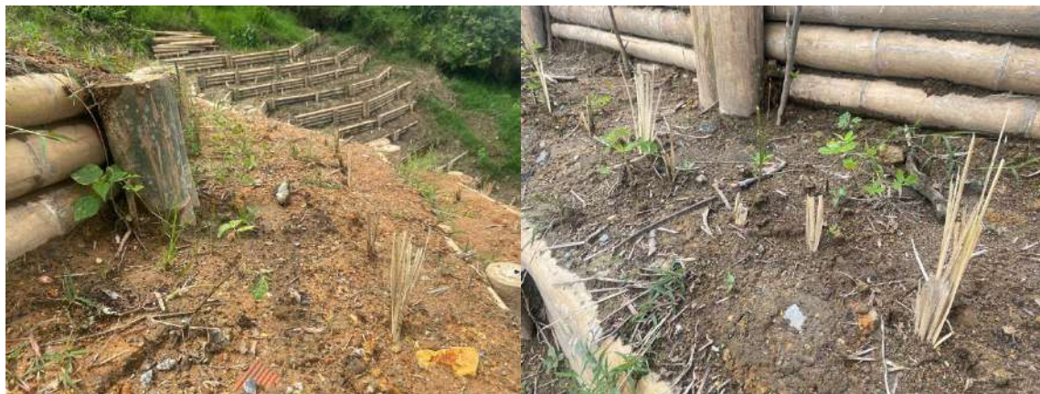
Revegetación con vetiver, empradizado con especies rastreras y estacas vivas. Parcela No 1
