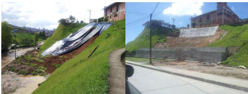
Diseño y construcción obras de estabilidad de taludes barrio Bengala Municipio de Manizales (2014)
