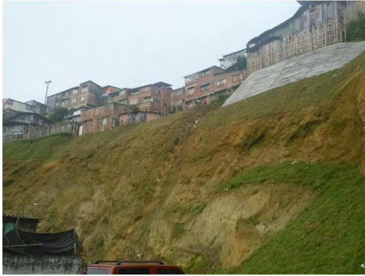
Obras de estabilidad de ladera barrio La Isla – Municipio de Manizales (2015)
