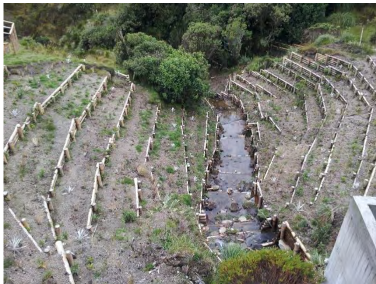
Obras de bioingeniería y control de erosión – Páramo de Letras Municipio de Marulanda (2013)
