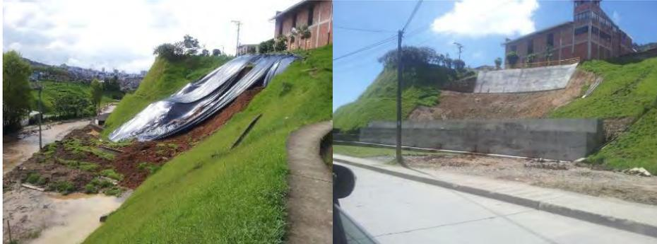
Ilustración 10: Diseño y construcción obras de estabilidad de taludes barrio Bengala Municipio de Manizales (2014)
