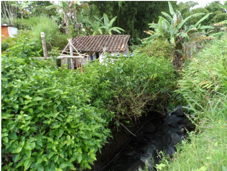
Figura 23.6. Vivienda localizada sobre llanura de inundación de la quebrada La Tolda en el Centro poblado de San Pedro, y propiedad de la Señora Donelia Acevedo Vélez
