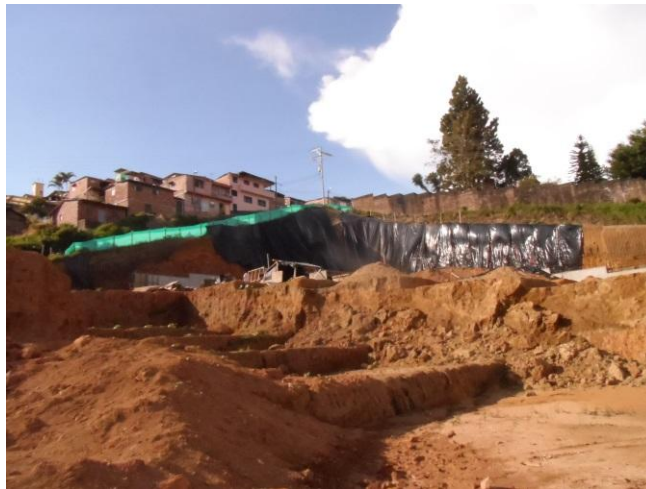
Figura 23.4. Cortes sobre materiales residuales lateríticos y cenizas volcánicas en el sector sur del Cementerio, evidenciados durante recorrido de octubre 28 de 2013.
