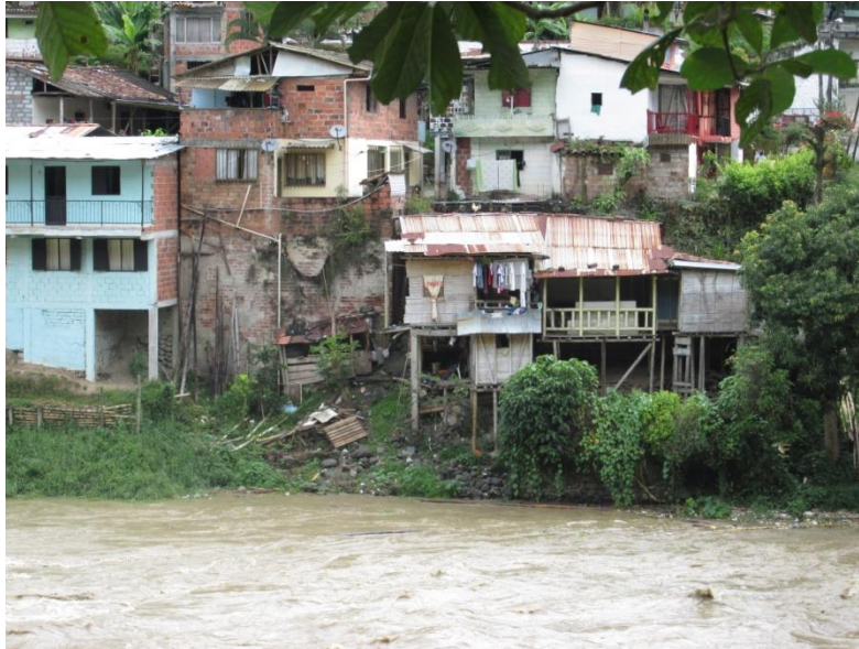
Figura 10. Localización de viviendas en la margen del río Cauca, ocupando zona de inundación del drenaje. Viviendas localizadas después del puente sobre el río Cauca.
