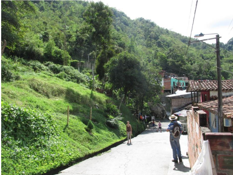
Figura 6. Punto crítico en zona de antiguo deslizamiento ya controlado y restaurado mediante implementación de medidas de mitigación
