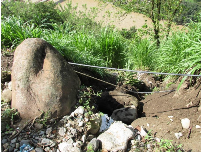
Figura 7. Tamaño de fragmentos de roca localizados en vía superior perimetral a cabecera de corregimiento, potencialmente removibles, a la altura del sector Los Chorros
