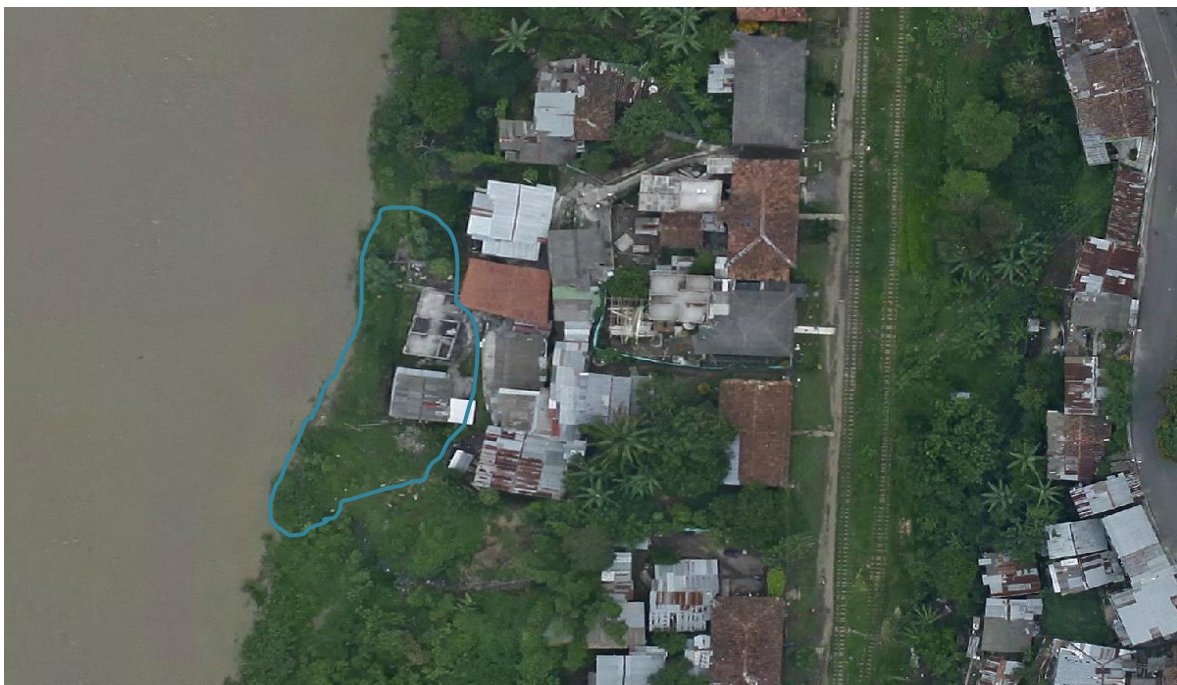
Figura 13. Grupo de viviendas localizadas en zona de inundación del río Cauca
