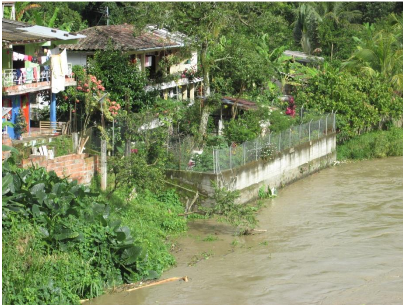
Figura 5. Punto crítico por inundaciones en las eventuales crecientes del río Cauca, en la cabecera de corregimiento
