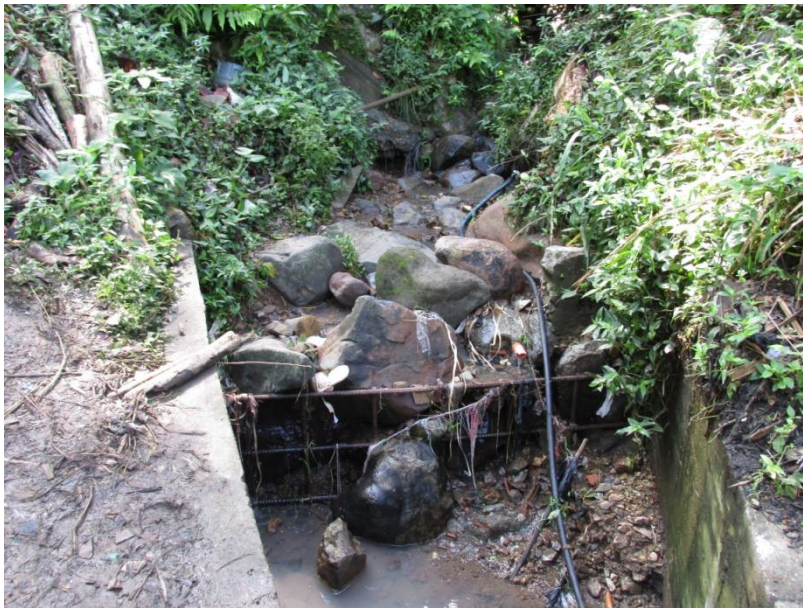
Figura 2. Dinámica torrencial de drenajes urbanos. Nótese la capacidad de arrastre de materiales, no obstante los bajos caudales
