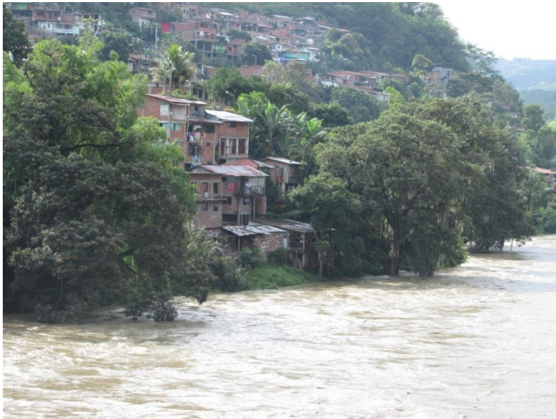
Figura 8. Sitio crítico por inundación localizado en la margen del río Cauca y detrás de la Cooperativa de Caficultores de la localidad
