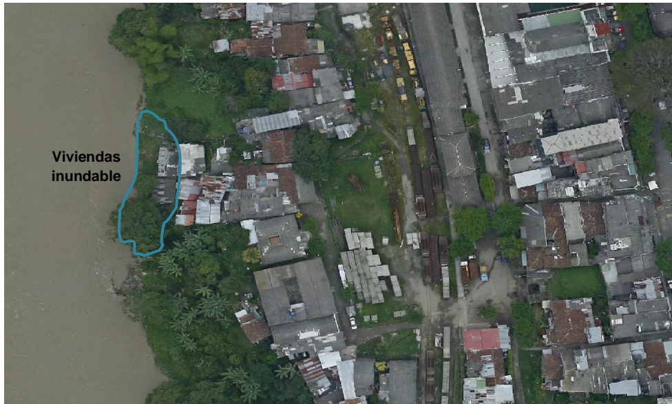
Figura 11. Viviendas expuestas a amenaza por inundaciones, corregimiento de Arauca
