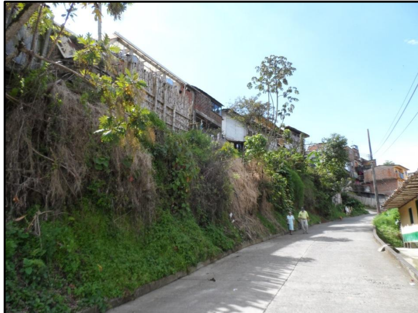
Figura 9.8 Laderas irregulares con sobrecargas estructurales y solares en algunos casos con cultivos o con deficientes coberturas, en el sector de la carrera 2 con calle 10, y deterioros de algunos tramos de las vías, con situación similar en diversos tramos del sector La ronda
