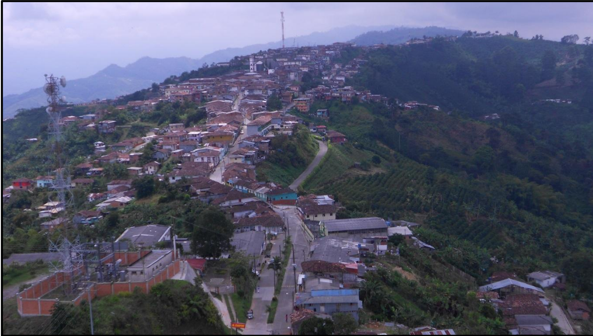
Figura 9.9. Taludes de las carreras 2 y 3, propensos a procesos de remoción en masa por alta pendiente y usos inadecuados
