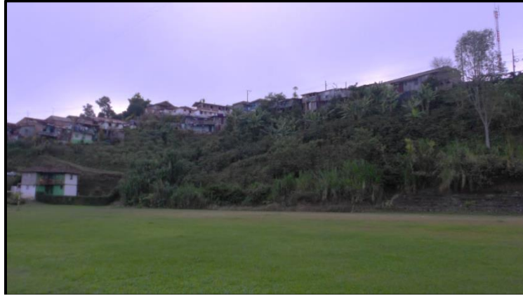
Figura 9.6. Ladera del sector La Pista, donde se presentan usos inadecuados e irregularidades en el perfilado de los taludes
