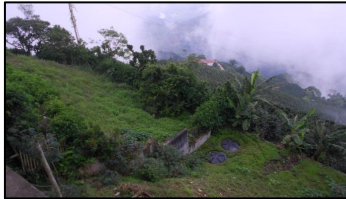
Figura. 9.16. Ladera de la parte posterior a la Subestación de Policía El Madroño, se resaltan cambios de pendiente, usos en cultivos y pastos, y sistemas sépticos.
