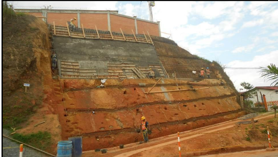
Figura 9.2 Secuencia superior de suelos residuales lateríticos derivados de rocas básicas, suprayacidos por diversos niveles de depósitos de ceniza volcánica, en el sector sur de la cabecera urbana de Belalcázar, aledaña al sector
