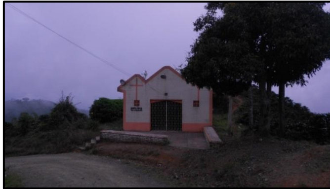
Figura. 9.15. Sector de iglesia y Centro Educativo Las Gaviotas, donde se presentan afloramientos de cenizas volcánicas con espesores en general inferiores a 8 metros
