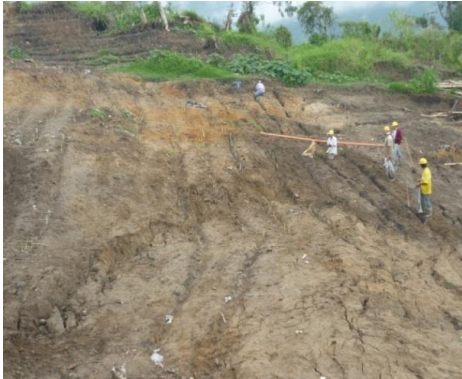
Obras de bioingeniería. Siembra de vetiver y trinchos con vertedero
