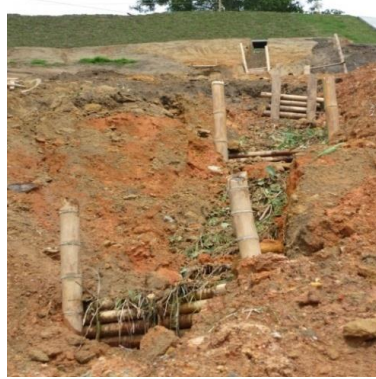
Obras de bioingeniería. Siembra de vetiver y trinchos con vertedero
