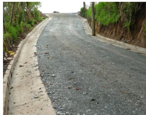
Cunetas vehiculares – manejo de aguas lluvias
