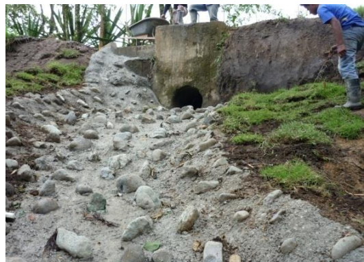
Enrocado con ligante de concreto
