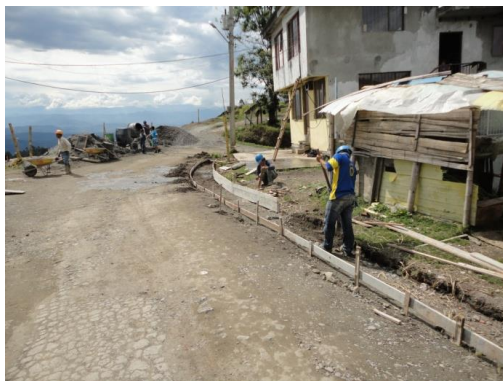
Cunetas vehiculares – manejo de aguas lluvias
