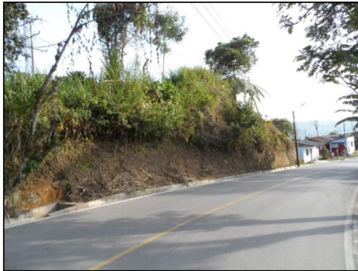
Figura 24.20 Taludes aledaños a la vía en la Inspección de Policía Municipal La Floresta donde se observan los depósitos de cenizas volcánicas.
