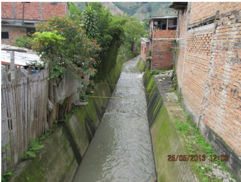
Figura 24.11. Ampliación de la sección hidráulica del tramo canalizado de la Quebrada Cameguadua, con relación al inicio de la canalización en el barrio Departamental.
