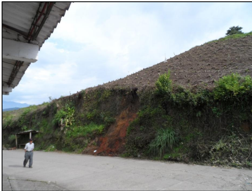
Figura 24.17. Detalle de taludes aledaños a la vía de acceso al Trébol, que requieren perfilados como medidas de mitigación
