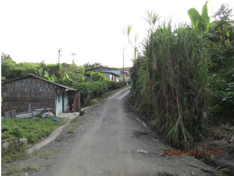
Figura 24.22. Talud potencialmente inestable sobre vía que de la Inspección de Policía La Floresta conduce a la vereda El Reposo
