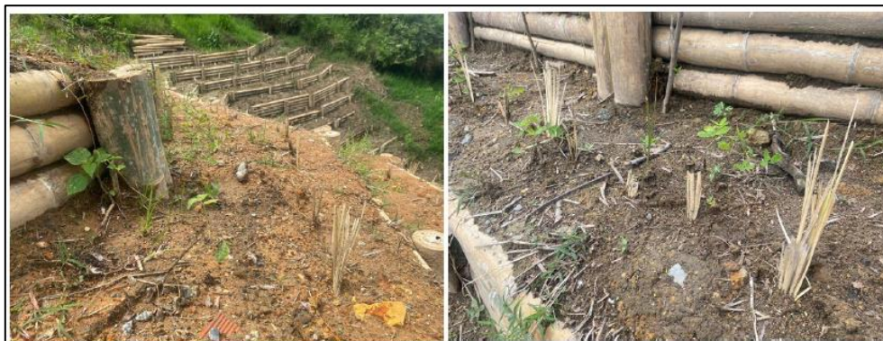
Imagen 5. Revegetalización con Vetiver, empradizado con especies y estacas vivas.
