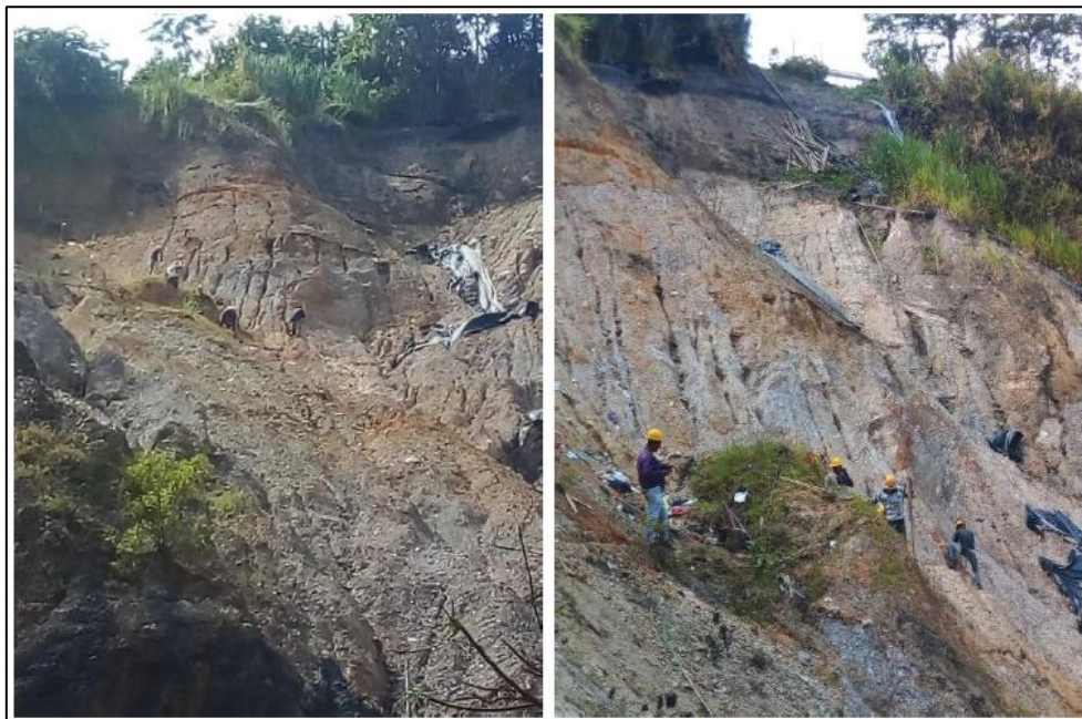
Imagen 1. Visualización de la cárcava antes de la instalación de la grilla. Fuente: Informe, actividades del contrato.
