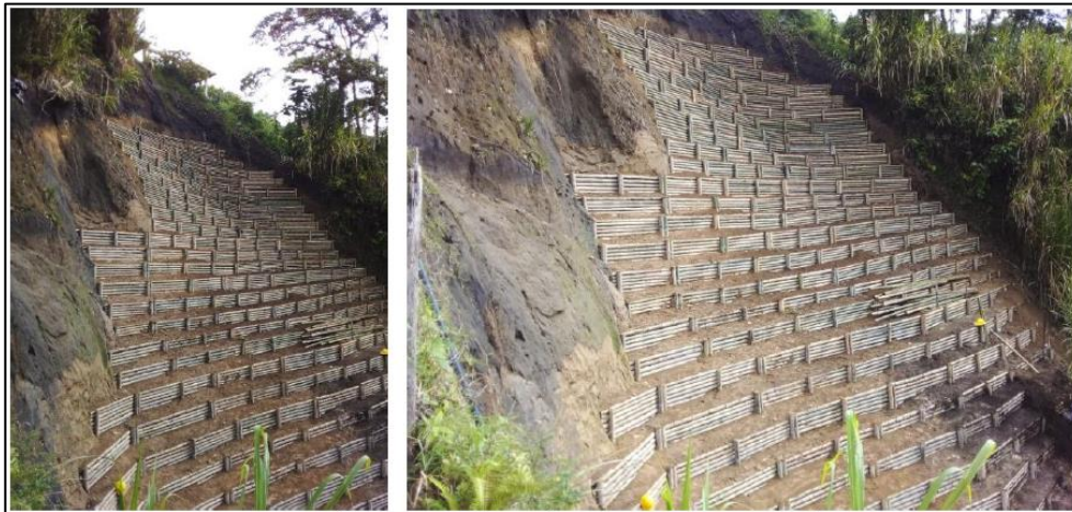
Imagen 2. Cárcava después de la instalación de la grilla. Fuente: Informe, actividades del contrato.
