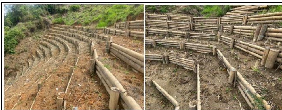
Imagen 4. Muros armados en tierra (parcela 1).
