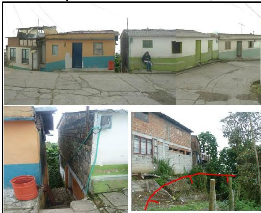
Figura 5.8. Diferentes aspectos del Sitio Critico SAM-2 en el cual se observa la falta de sumideros en la calle (arriba) el zaguán por donde baja el agua de escorrentía (inferior izq) y la parte trasera de las casas afectadas por un deslizamiento (inferior. Der)
