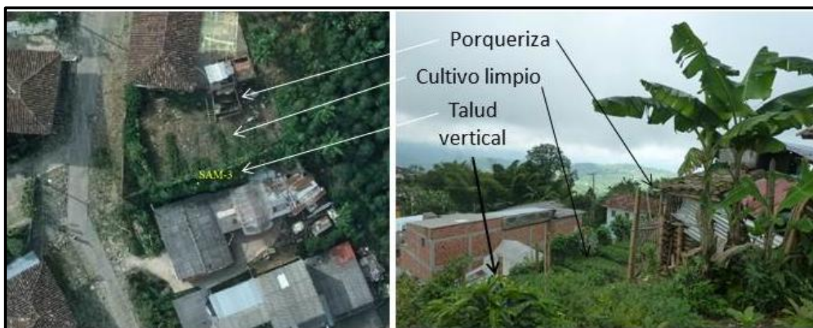
Figura 5.9 Sitio crítico SAM-3: Vista en planta y lateral de la sobre-excavación en el talud de cenizas para la construcción de una casa, con presencia de cultivos limpios y porquerizas en la vivienda ubicada en la parte superior (Der.)
