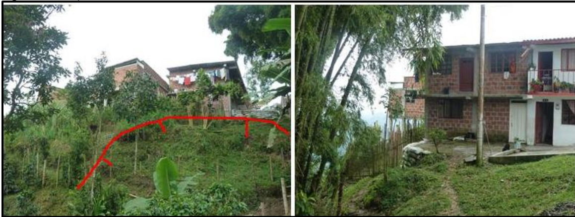
Figura 5.10 Sitio crítico SAM-4: pequeño escarpe sobre un talud en el Barrio Cabuyales (Izq.) y medida provisional de protección con sacos de suelo para acondicionar la entrada a una vivienda (Der.)
