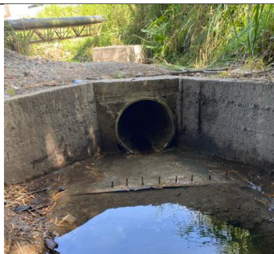
Ilustraci n 18. Box Culvert, canalizaci n realizada en Chinchin , Caldas.
