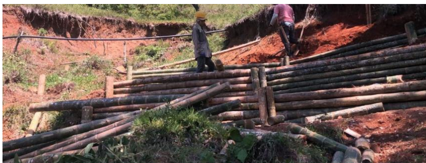
Ilustración 37. Construcción de obras temporales de estabilidad en la orilla de un cauce.
