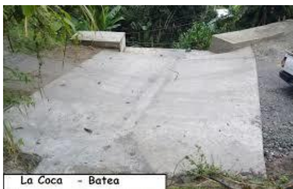
Ilustración 33. Ejemplo de una batea que fue reparada en el marco de un permiso de Ocupación de Cauce.
