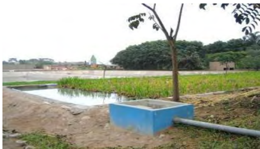
Sistema de tratamiento tipo – Humedal de flujo subsuperficial
