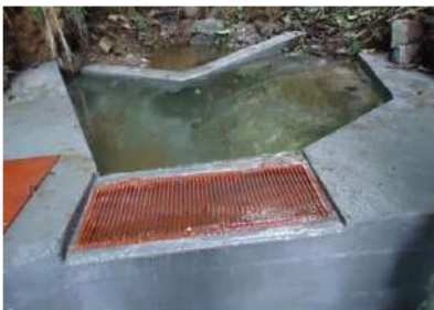
Bocatoma Confines - Samaná
