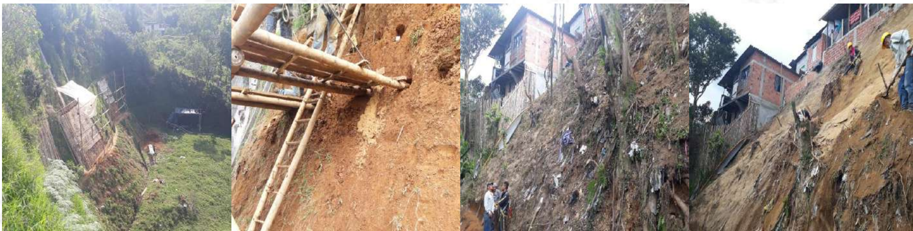
Sectores La Floresta (pantalla y anclajes) y Polideportivo (pantalla, anclajes y obras manejo de aguas superficiales). Municipio de Villamaría
