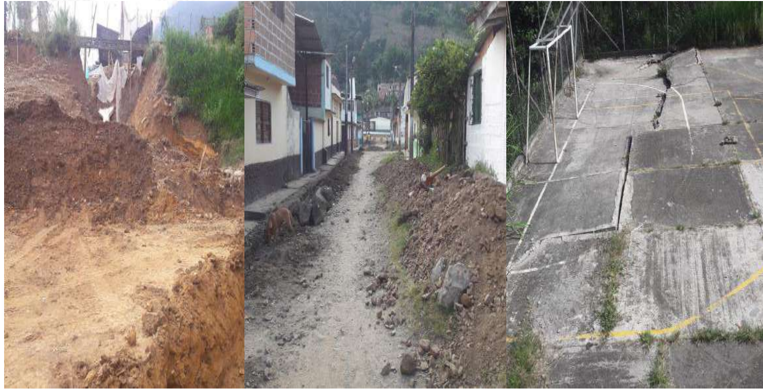
Sectores Terminal de Transportes (Box coulvert) – Bonafont (manejo aguas escorrentía) – Santa Ana (pantallas) – La Estancia (refuerzo muro). Municipio de Riosucio
