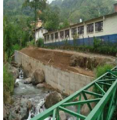
Obras de estabilización y prevención del riesgo. Resguardo Indígena San Lorenzo
