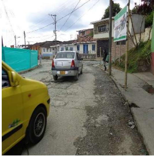
Sector La Bomba – Hospital. Municipio de Aguadas
