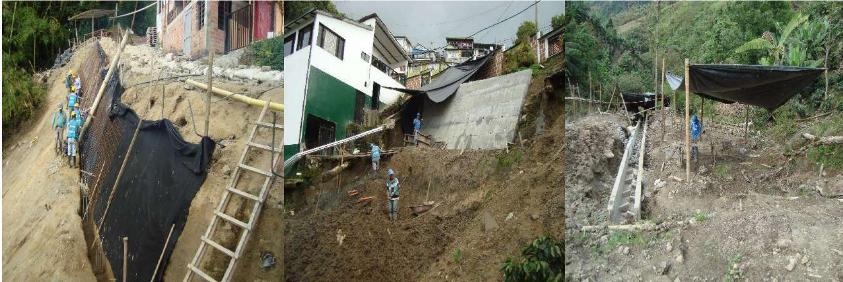
Sectores Arenillo – Morrogordo (pantalla) – Vía Santa Clara – Los Halcones – San Peregrino – La Pola – La Bodega – Torre IV (muro de contención). Municipio de Manizales
