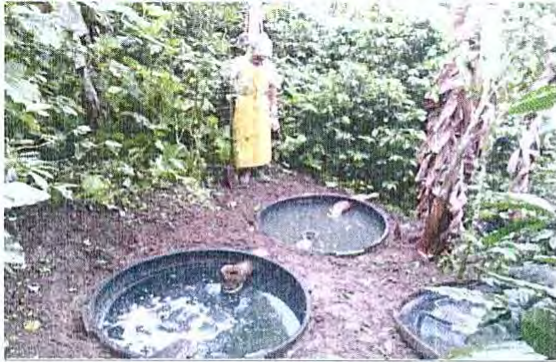
EL SISTEMA SEPTICO REQUIERE MANTENIMIENTO.ANTES
