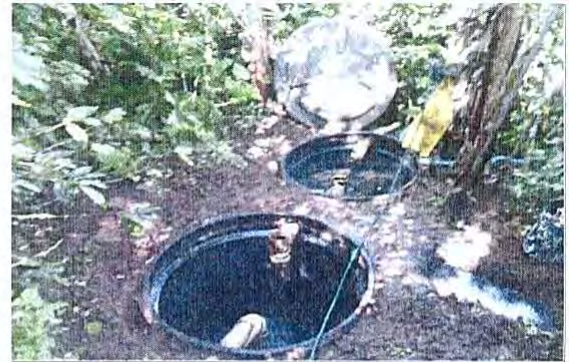
SE RETIRARON TODOS LOS LODOS DEL POZO SEPTICO.DESPUES
