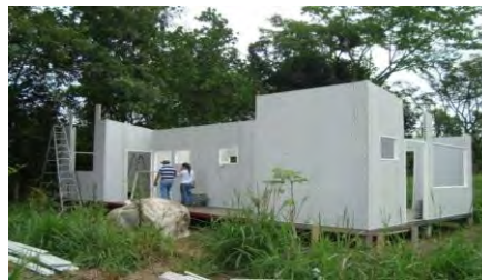
Adecuación del CAVR Montelindo
