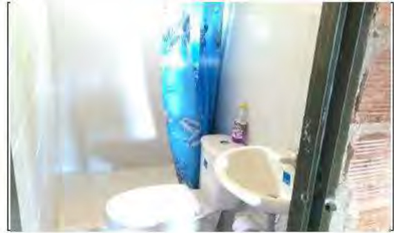
CASETA SANITARIA DESPUES.
