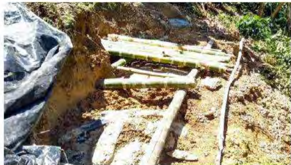
TANQUE SÉPTICO Y FILTRO ANAEROBIO INSTALADOS EN LA VIVIENDA. DESPUÉS
