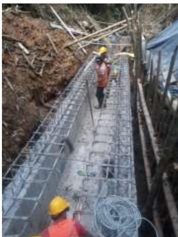
Foto. Box Coulver, Relleno Sanitario los Eucaliptos
