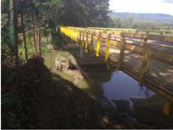
Fotos. Infraestructura que afecta la dinámica natural del río y socavación de orillas.
