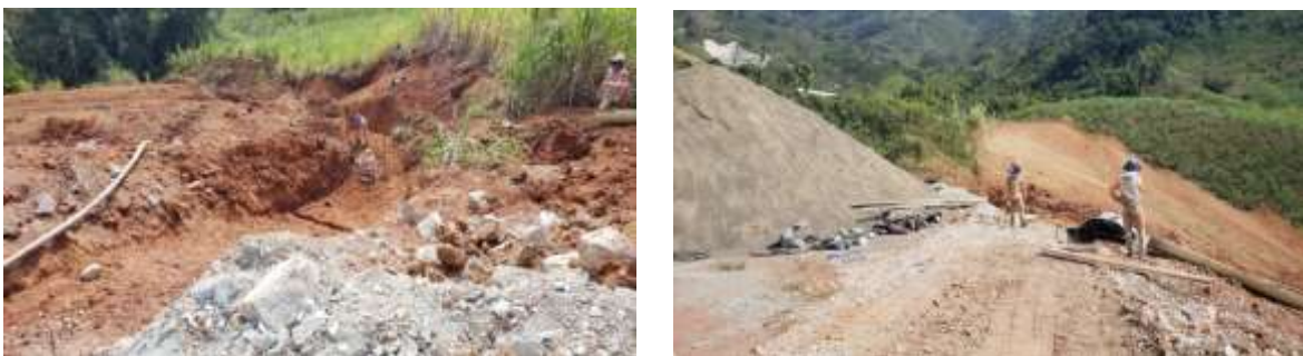
Fotografías. Seguimiento a escombrera Pacífico 3 – Vereda la Tesalia – Viterbo Caldas – 2019, Oscar D. Moreno.
