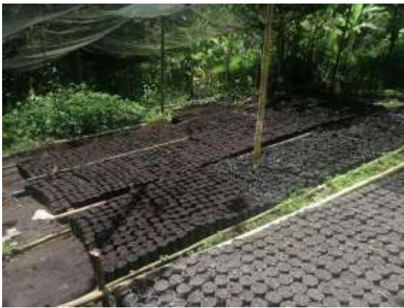
Foto. Preparación de la infraestructura del vivero. Imagen de propiedad del resguardo Cañamomo Lomapieta. Convenio 249- 2018
