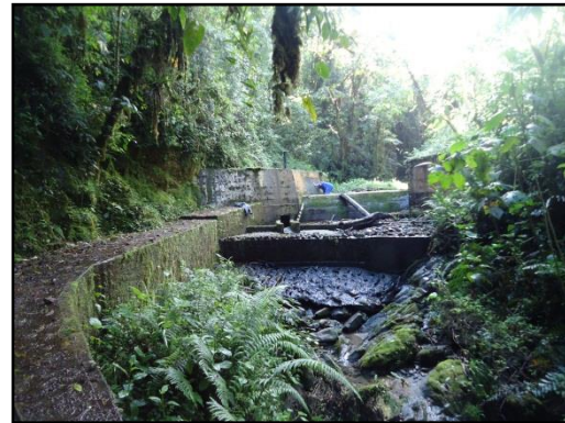
Figura 6. Captación Quebrada Pinares. Fuente: Propia.
