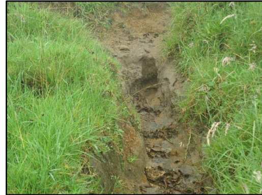
Figura 61. Fenómenos de socavación y cárcavamiento en pasos de herradura. Sector parte alta de la Quebrada La Arenosa. Fuente: Propia.
