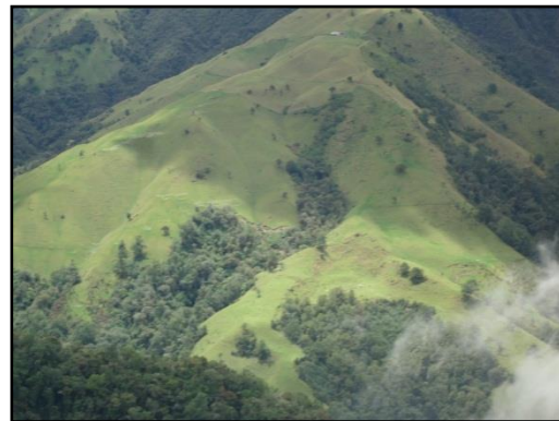
Figura 66. Movimiento en masa observado en la parte alta del ABACO del Río Blanco. Fuente: Propia.
