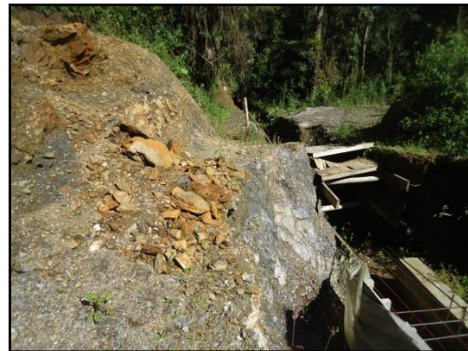
Figura 34. Esquistos Negros aflorantes en la conducción del ABACO de la Quebrada Pinares, zona de movimiento en masa activo. Fuente: Propia.
