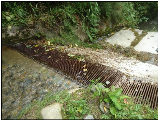
Figura 5. Captación Quebrada La Ye, tributaria de la Quebrada Olivares. Fuente: Propia.
