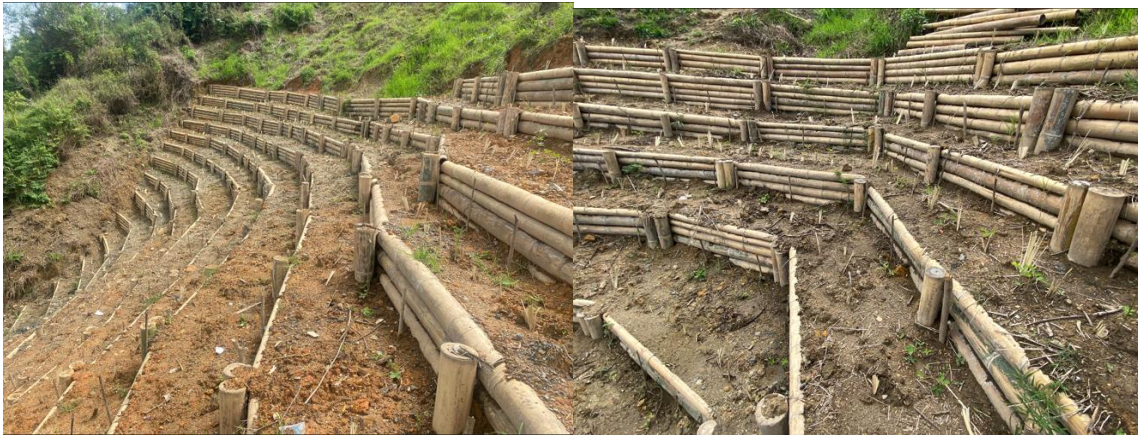
Muros armados en tierra Parcela No 1.
