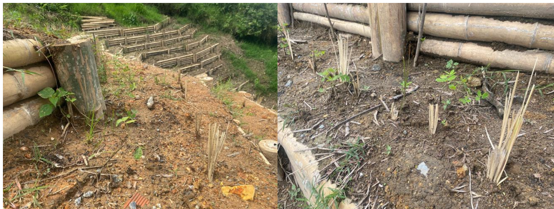
Revegetación con vetiver, empradizado con especies rastreras y estacas vivas. Parcela No 1
