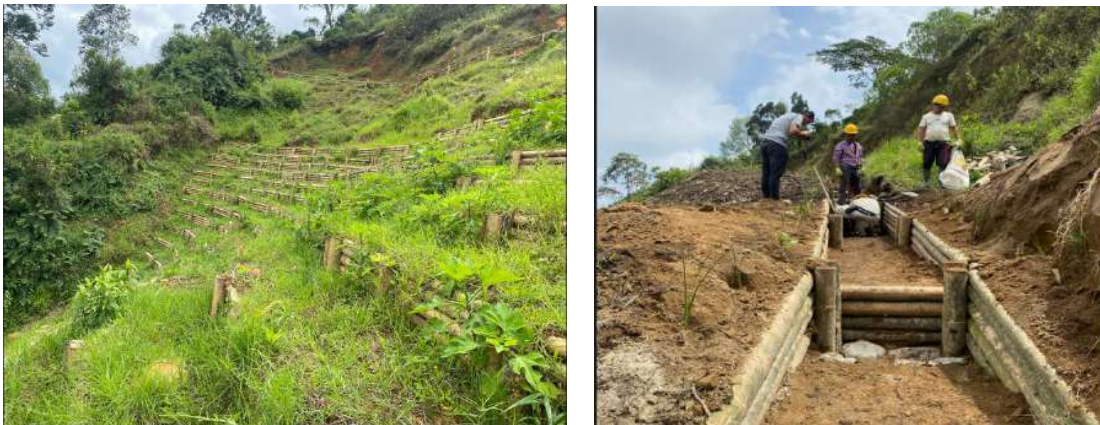
Combinación de muros con revegetalización y entibados en guadua y disipadores.
