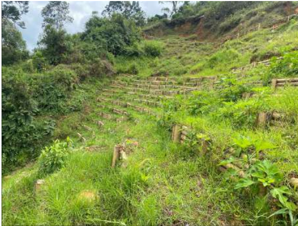
Combinación de muros con revegetalización y entibados en guadua y disipadores. Distrito de Conservación de Suelo DCS Guacas Rosario, sector Cárcava El Tablazo
