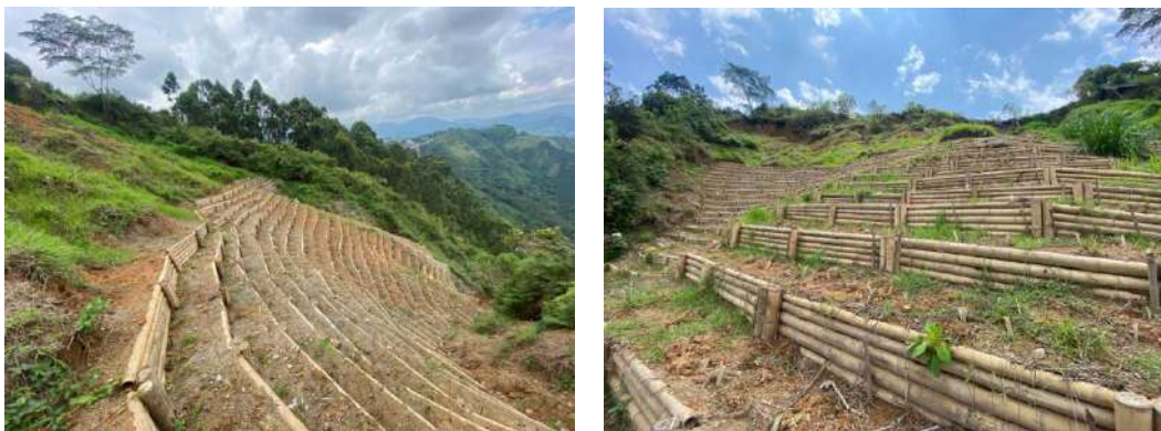
Muros Armados en Tierra. Distrito de Conservación de Suelo DCS Guacas Rosario, sector Cárcava El Tablazo
