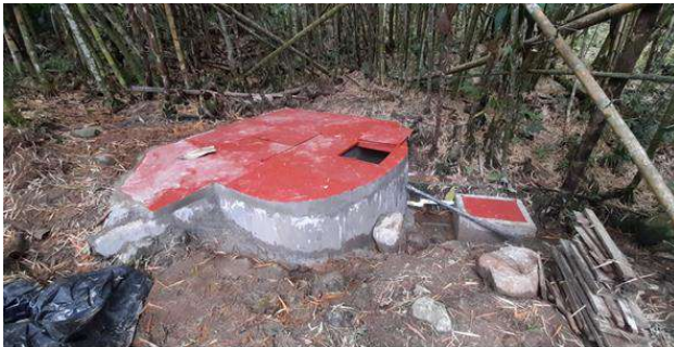
REPARACION DE TANQUE EXISTENTE-CONSTRUCCIÓN DE CAJAS Y COLOCACION DE TAPA, SECTOR QUIMBAYA - RESGUARDO ESCOPETERA
