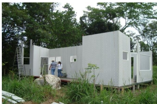
Adecuación del CAVR Montelindo
