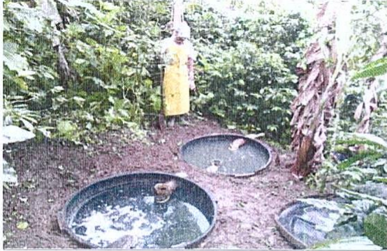
EL SISTEMA SEPTICO REQUIERE MANTENIMIENTO. ANTES
