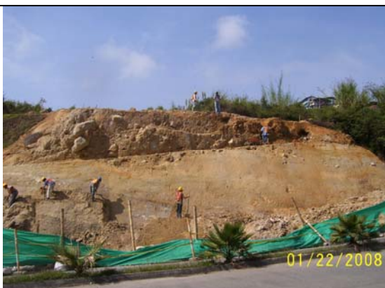
obras de estabilidad de taludes y de manejo de aguas lluvias en el barrio La Isabela del municipio de Villamaría.
