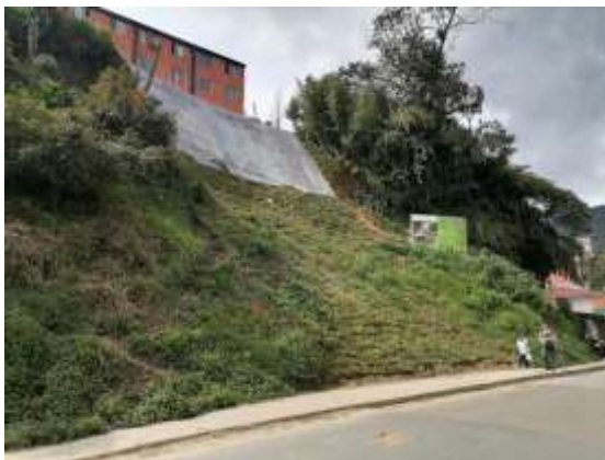
Sector Obras Públicas
