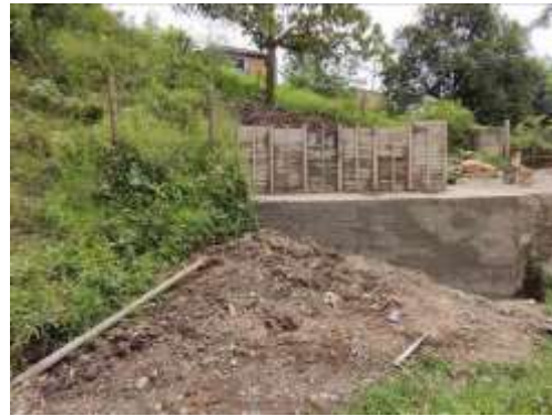
Obras quebrada Limones
