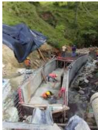
Box Culvert Quebrada Matadero (Obras financiadas con recursos del Proyecto 10)
