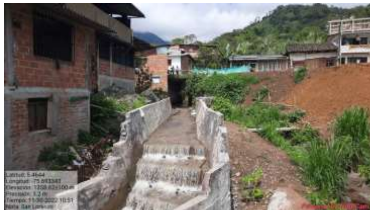
Vista general del sector intervenido mediante el convenio 210-2021 (quebrada Honduras)
