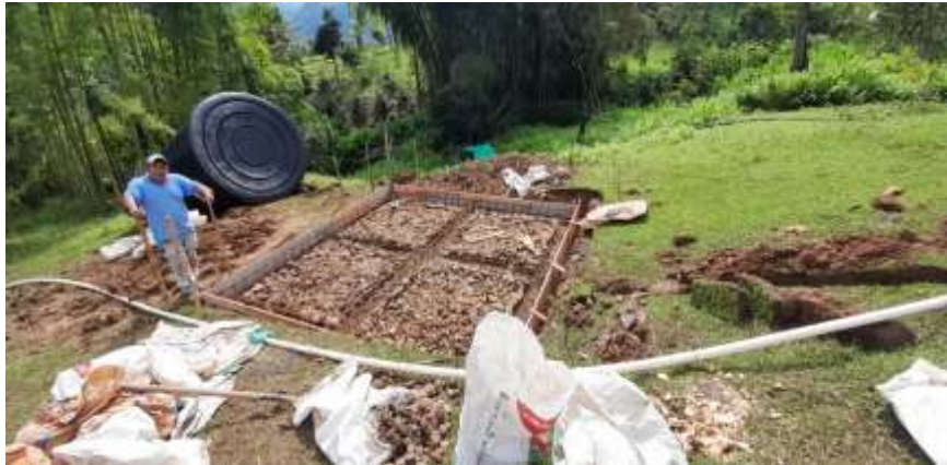
Construcción de losa de cimentación
