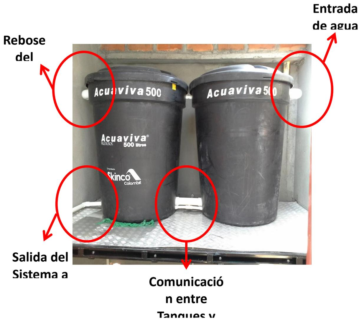
Figura1. Sistema de Almacenamiento de agua lluvia con capacidad para 1000 litros.
