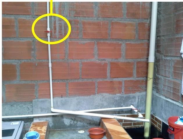
**Registro de Foto 8. Figura . Válvula para Drenaje del Sistema. (Tomado Manual de Operación y Mto. Del sistema)**
