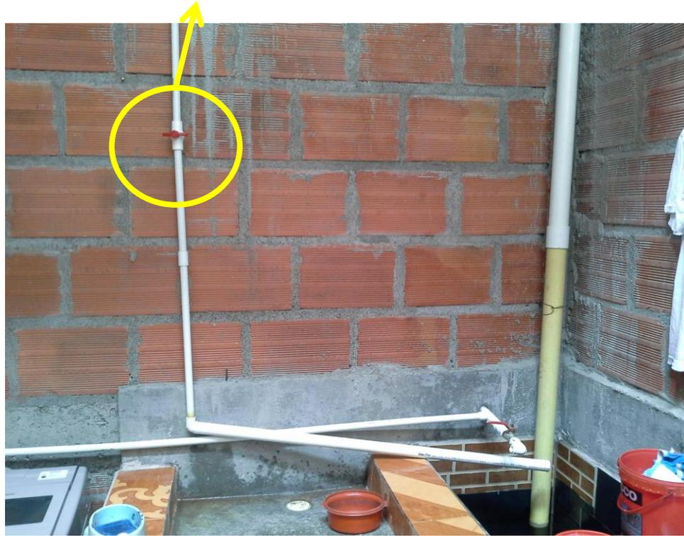
Figura 5. Válvula para Drenaje del Sistema.
