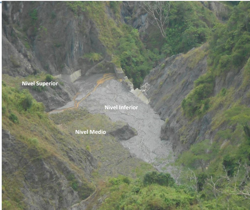
Figura 27.7. Dique de colmatación en la zona central de la cárcava El Tablazo, donde se observan los remanentes de las terrazas superior y media y la evacuación de sedimentos de la terraza inferior hacia el sector de apoyo del dique sobre la margen izquierda.
