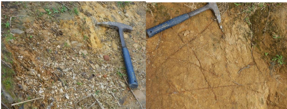
Figura 27.40. Niveles I y II de meteorización de las rocas sedimentarias del Complejo Quebradagrande, en sector de El Palo (Izq). Nivel I de meteorización del basamento meta-sedimentario observado en cortes del talud a la entrada del sector de El Plan (Der).
