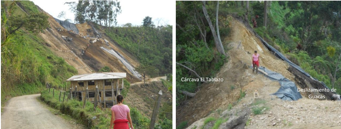
Figura 27.8. Deslizamiento en la vía Alto Tablazo-Guacas, estación AT-4 en la Figura 27.2 (Izq). Captura de drenaje por la unión de las coronas de la cárcava del Tablazo y del deslizamiento de Guacas, estación AT-7 en la Figura 27.2 (Der).
