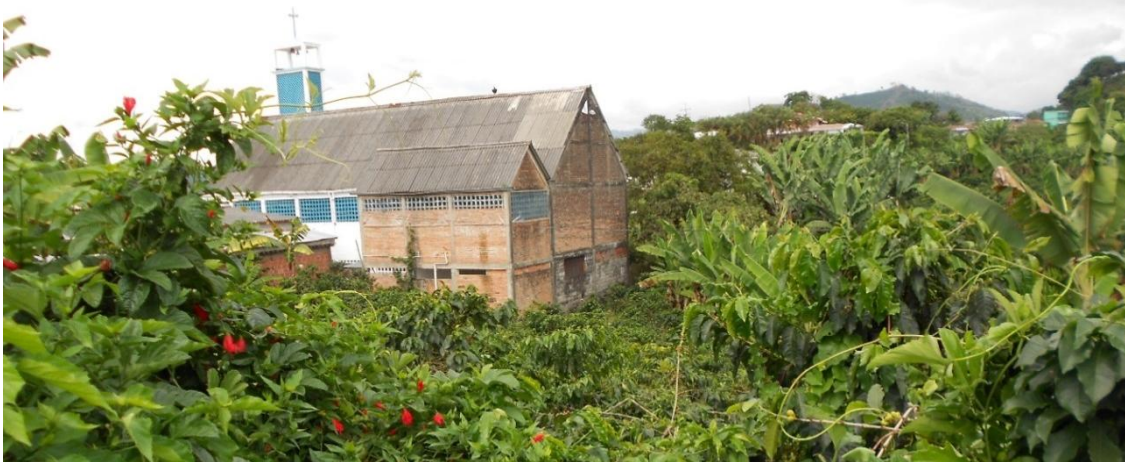
Figura 27.51. Ladera Sur del sector central del poblado, donde el uso del suelo y las pendientes suaves protegen los taludes de fenómenos de remoción en masa.
