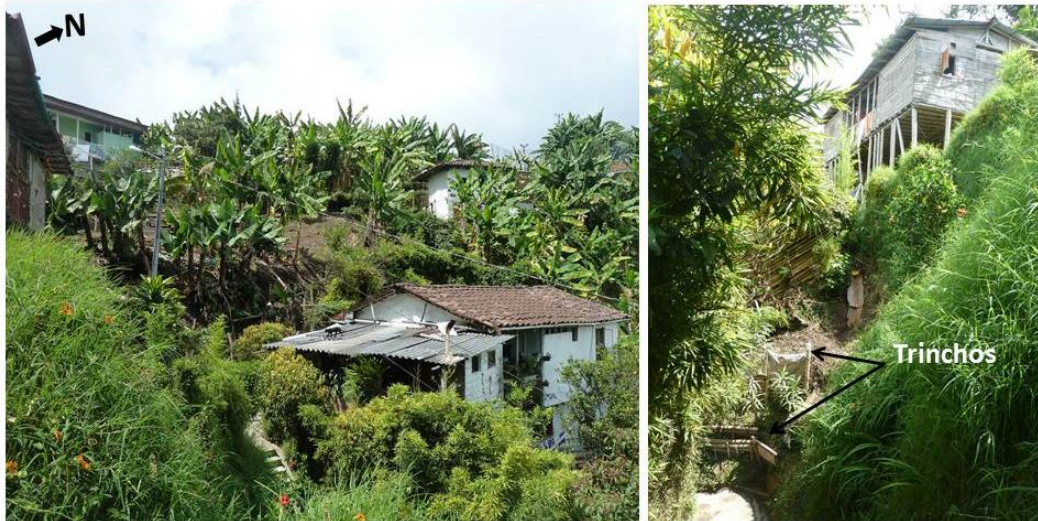
Figura 27.13. Aspectos del Sitio Crítico BT-2. Talud vertical y cultivos limpios crean amenaza para las viviendas en la parte inferior. Talud vertical que presenta caídas de suelo (Izq.) en el Bajo Tablazo (Manizales).
