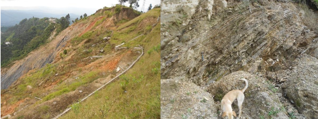
Figura 27.4. Nivel I y II de meteorización de las rocas sedimentarias del Complejo Quebradagrande en la corona actual (11.2013) de la cárcava remontante de El Tablazo (Izq). Nivel II de meteorización del basamento observado en cortes del talud en la carretera que conduce a Guacas (Der).
