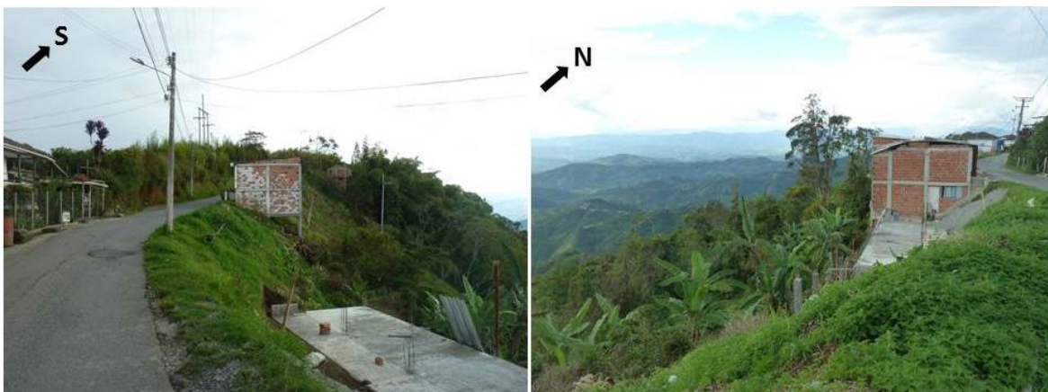
Figura 27.35. Falta de obras para manejo de aguas de escorrentía (Izq.) y construcción en laderas muy empinadas (Der.) son las mayores problemáticas en La Aurora (Manizales)
