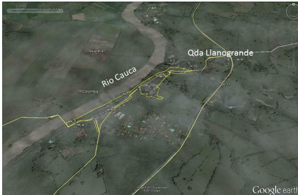
Figura 27.17. Meseta sobre la cual se ubica el Kilómetro 41 sobre flujos de escombros (Qf12) (Manizales)(Imagen Google Earth 2013).
