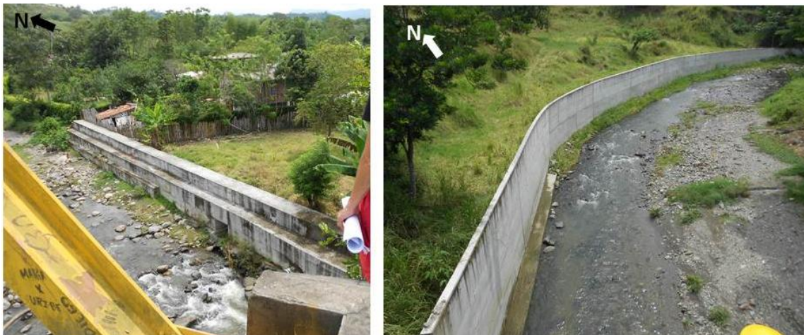
Figura 27.21. Muro de gaviones en la desembocadura de la quebrada Llanogrande en el límite Norte del corregimiento (Izq.) y obra contra socavación de orillas en el cruce de la Quebrada con la vía a Medellín (Der.)
