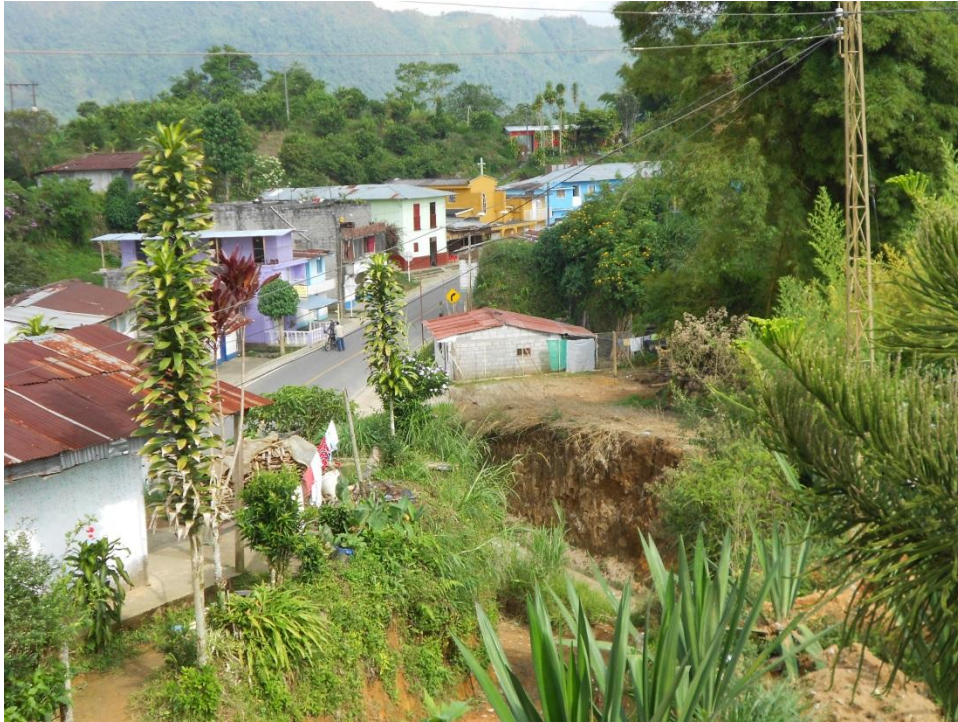
Figura 1.3. Parte Central del corregimiento Santa Elena, se observan los cortes de los taludes a lado y lado de la vía pavimentada que comunica Cañaveral y el casco urbano de Marquetalia, dirección de la Fotografía N255°, en dirección a Marquetalia.
