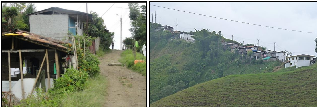
Figura 7.3. Materiales de construcción (derecha - Orientación N135°) y disposición escalonada de las viviendas (izquierda. Orientación N175°)
