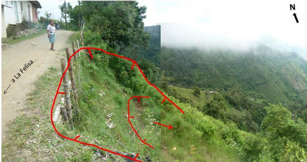
Figura 18.12. Sitio Crítico SB-2. Proceso erosivo originado en el mal manejo de aguas de escorrentía que afecta la vía a La Felisa (Fecha fotos: 22.05.2013).
