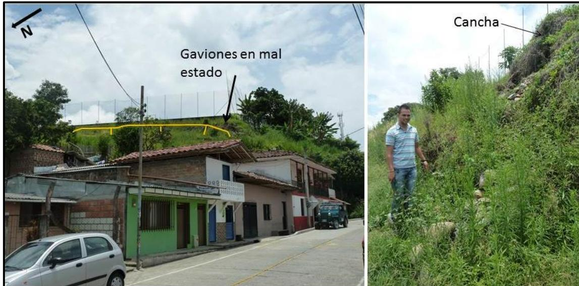
**Figura 8.4.** Sitio crítico LaP-1: escarpe y depósito en el talud Norte de la Cancha de fútbol (izq.) con un sistema de contención en Gaviones en mal estado (der.)
