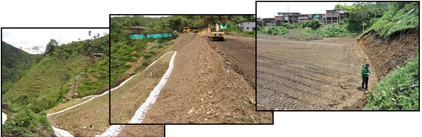
**Figura 1.46.** Proceso de perfilado de la zona de afectación por un proceso de remoción en masa en la parte norte del caserío Soledad Alta. Dirección de las fotografías N180°.
