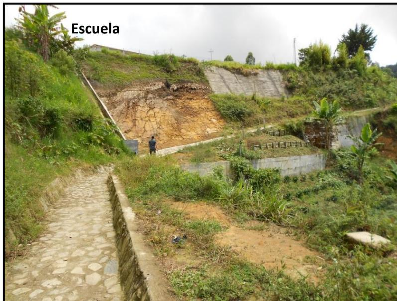
**Figura 1.42.** Pantalla de protección en construcción (abandonada sin acabar según información de la población) del talud norte por un proceso de remoción en masa relacionado con el invierno de 2010 en la parte norte del caserío El Higuero. Dirección de la fotografía N345°. Para su ubicación ver Figura 1.40. En la parte superior derecha de la fotografía se observa un nuevo proceso de remoción que afecta al talud de la escuela.
