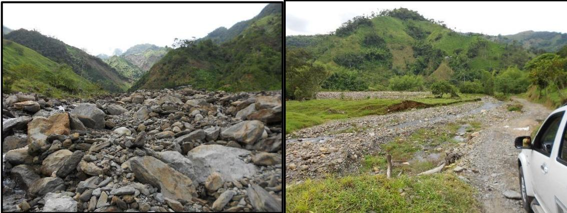
**Figura 1.28. Izquierda.** Deslizamiento activo sobre drenaje que atraviesa la carretera 5 km antes del corregimiento de Pueblo Nuevo, que genera con frecuencia eventos gigantes de flujos de escombros, orientación de la fotografía N80°. **Derecha:** Socavación de la margen derecha del Río Samaná, que afecta la carreteras 3 km antes de Pueblo Nuevo.
