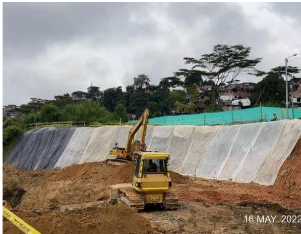
Perfilado de taludes
