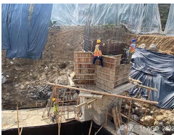
Construcción Cámara quebré de alineamiento
