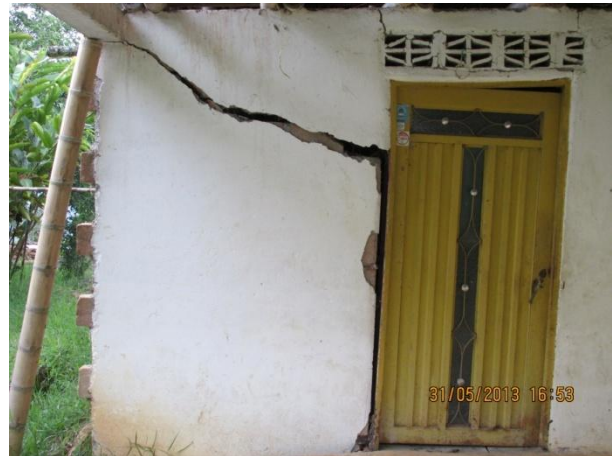
Figura21.11. Viviendas localizadas en zona de influencia directa de subsidencia local que compromete estabilidad de construcciones y banca de vía
