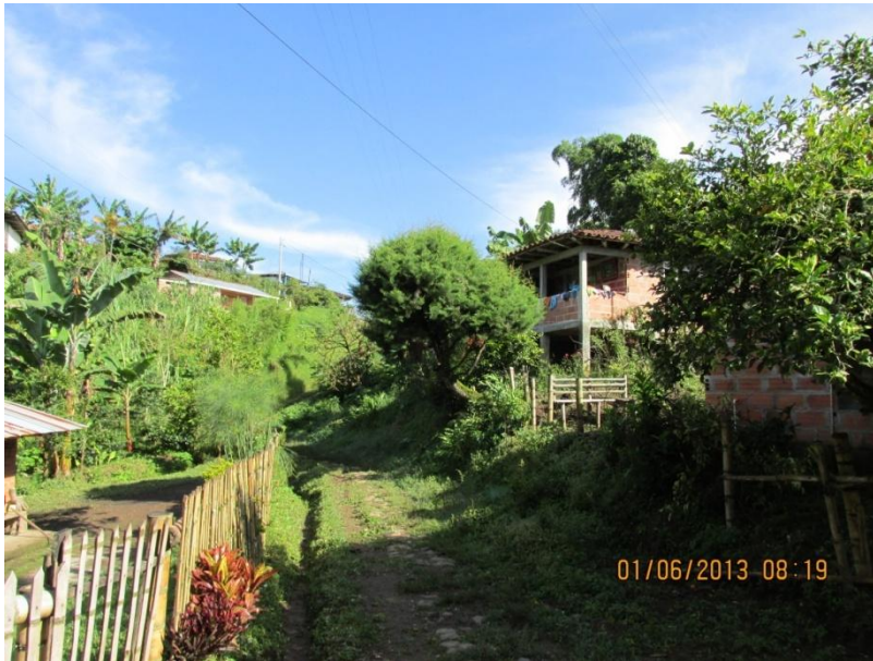
Figura 21.28. Detalle de la baja densificación urbana asociada a los accesos peatonales que comunican la cabecera de Corregimiento. Peventonales de acceso destapadas y sin obras de arte que garanticen el manejo y control de aguas de escorrentía
