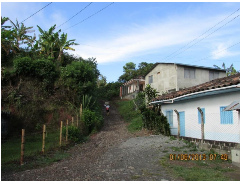
Figura 21.27. Afloramiento en talud subvertical de suelos residuales de la Formación Amagá. Nótese los accesos vehiculares/peatonales destapados y sin el adecuado manejo y control de aguas de escorrentía
