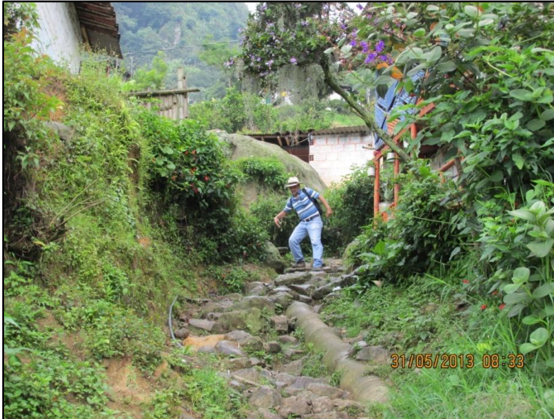
Figura 21.17. Detalle de estado de accesos peatonales parte alta Corregimiento de San Jerónimo y trazado de sistema de alcantarillado
