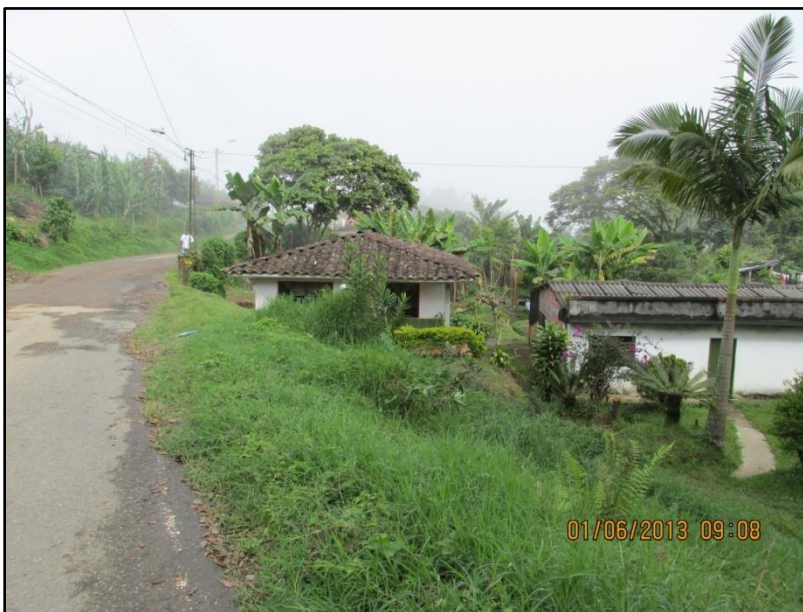
Figura 21.26. Detalle de viviendas localizadas en bajos o depresiones del terreno, expuestos a empozamientos y/o inundaciones
