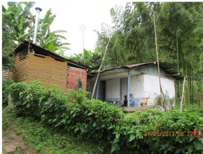
Figura 21.18. Construcción típica de los habitantes del caserío San jerónimo. En general las viviendas son de un nivel y construidas en bahareque
