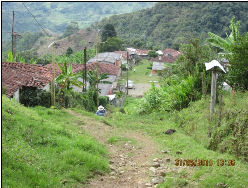
Figura 21.15. Panorámica del Corregimiento desde parte alta (Escuela). Apréciase estado de vías, cubiertas y pendientes. Sobre vías peatonales, ausencia notoria de manejo de aguas de escorrentía
