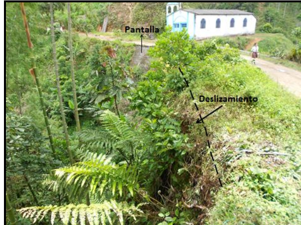
Figura 1.29. Pantalla presente en solo una parte del talud en la parte NW del caserío en la salida de la vía que conduce a Santa Bárbara, seguido de un deslizamiento. Hacia la entrada del Caserío.
