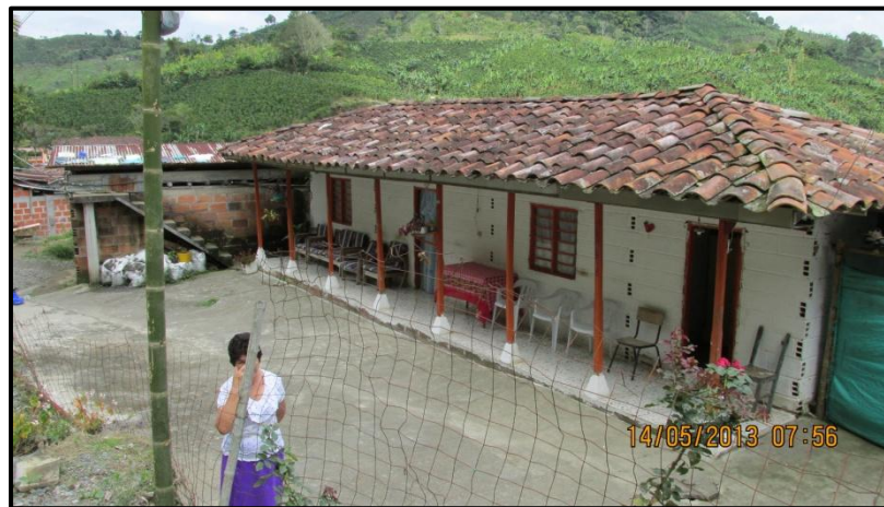
Figura 11.7. Vivienda contigua a predio de fotografía, fue reubicada por afectación de caída de materiales
