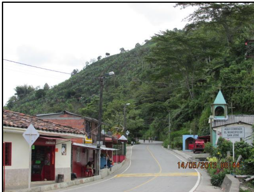
Figura 11.5. Panorámica de localización caserío Quebra de Santa Bárbara. Al fondo puede notarse la presencia de talud subvertical, con registros históricos y recientes de actividad erosiva. El talud eventualmente puede comprometer las primeras viviendas del caserío, en sentido San José-Las Margaritas
