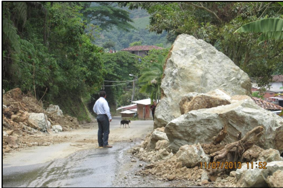
Figura 11.2. Deslizamientos recientes sobre vía San José-Quiebra de Santa Bárbara-Las Margaritas. Caída de rocas de considerable diámetro que generan pérdida de movilidad y eventualmente riesgo sobre viviendas de caserío.
