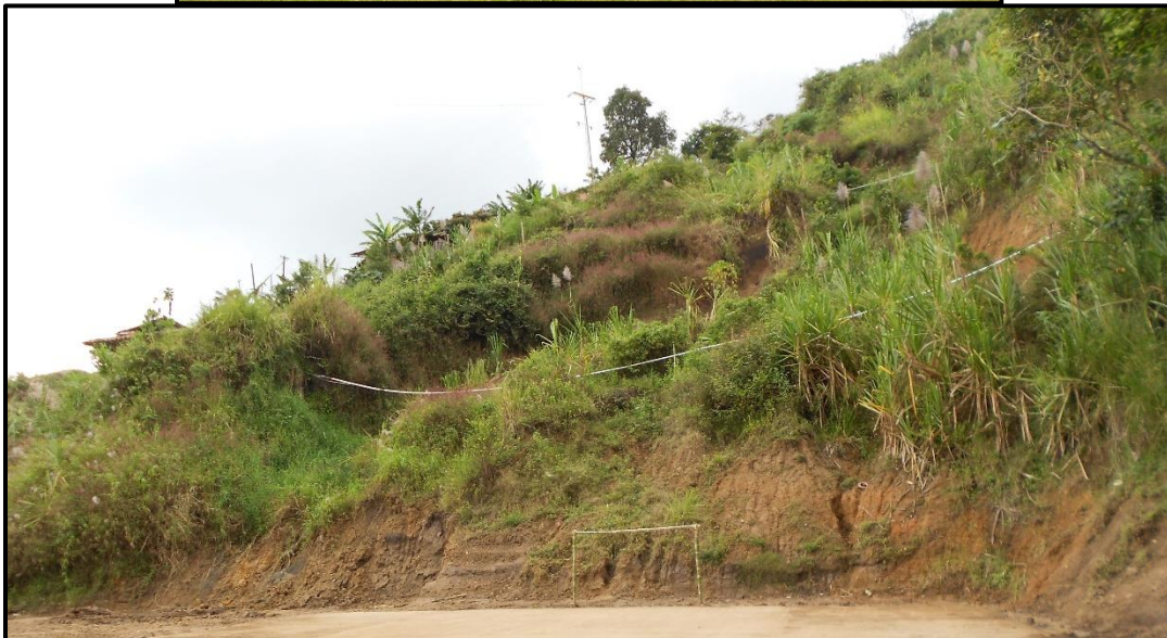
Figura 20. 30. Arriba. Panorámica general del deslizamiento complejo sobre el talud occidental de la zona deportiva del centro poblado Los Cuervos. Abajo: Detalle del deslizamiento, dirección de la fotografía N280°.
