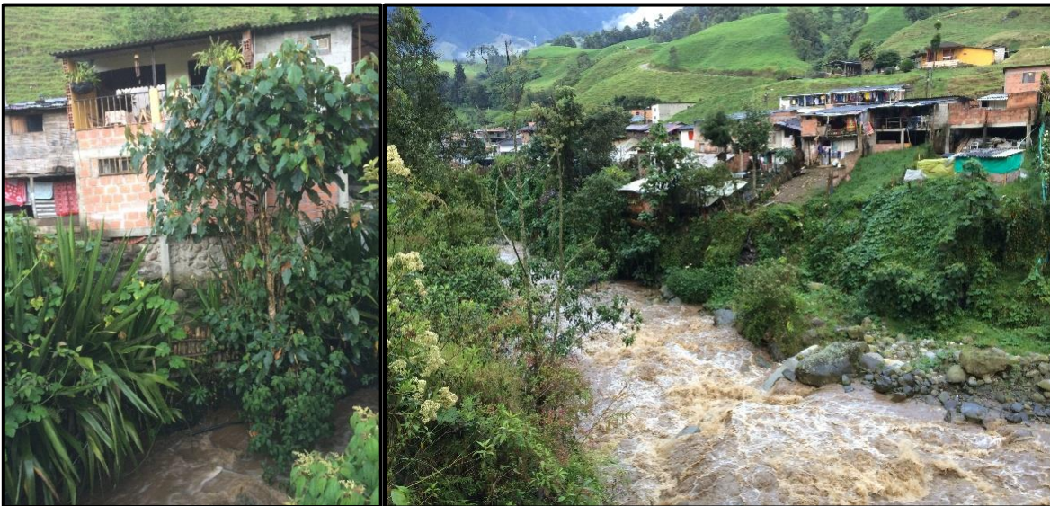
Figura 20.17. Ejemplos de construcciones cerca a los drenajes en el centro poblado de Gallinazo. Izquierda: Casa directamente sobre la margen derecha del drenaje a la salida a Termal del Otoño. Derecha: Ampliación de viviendas en la margen derecha de la Quebrada California antes del puente que da acceso al caserío.
