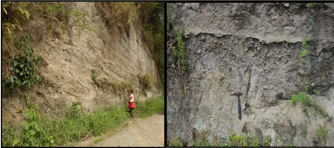
Figura 20.23. Izquierda: Talud a la entrada de Río Claro Nuevo, mostrando el aspecto del depósito de flujo piroclástico de Río Claro- Molinos. (Dirección de la fotografía N95°). Derecha: Detalle del depósito de flujo piroclástico mostrando una zona de concentración de pómez.
